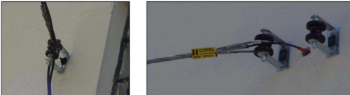
Exemplo de ancoragem com conjunto armação secundária de um estribo com isolador Roldada de porcelana
